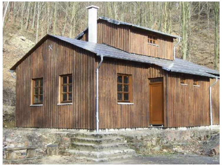
Bald fertig: das neue Zechenhaus am Feggendorfer Stollen
